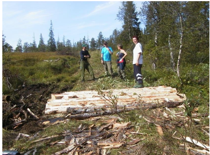
Bygging av kavlbru ved opprustning av Giltmarkveien i Kvam
